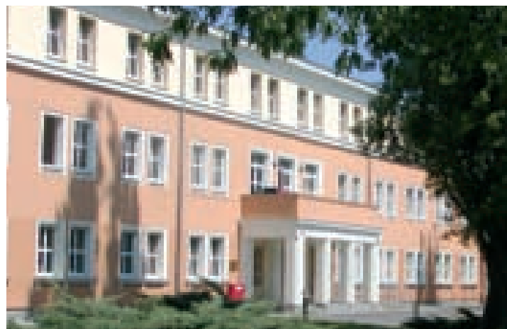
Das Wohnheim Treptow des Unionhilfswerkes in der Eichbuschallee 8
